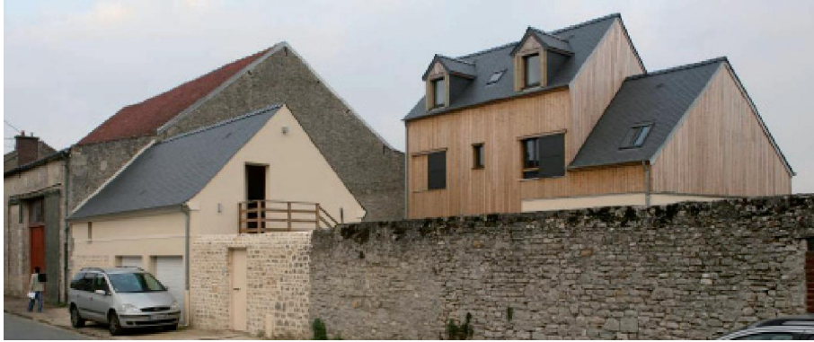
Maison en bois à Barbery (60). Un dialogue avec le bâti ancien est instauré.
