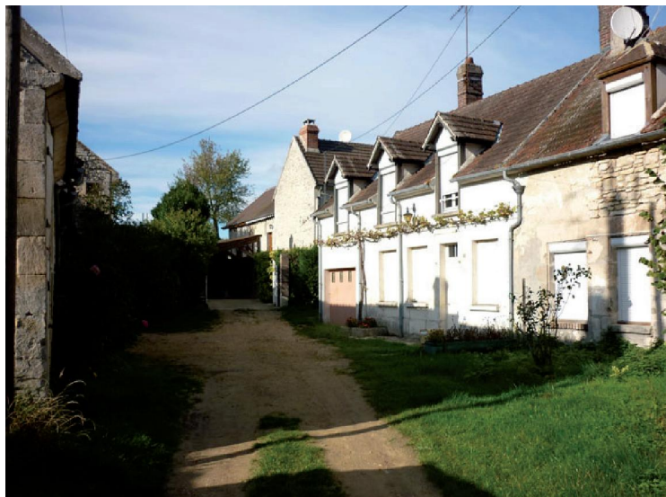
La cour commune existante au Fond Maillet : une référence d'organisation du bâti nouveau pour ce hameau au caractère fort et homogène.
