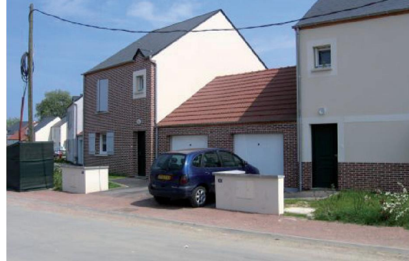
Mitoyenneté établie par les garages permettant d'assurer un continuum bâti
